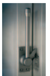
Closing handle „Z“ Abschlussklinke „Z“
