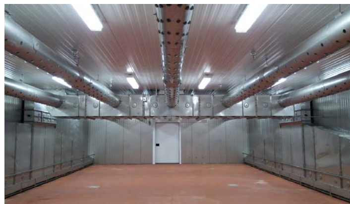
Obr. č. 3: Pohled do klimatizované komory Mauting KMD 84 Cross Flow, instalace v USA
